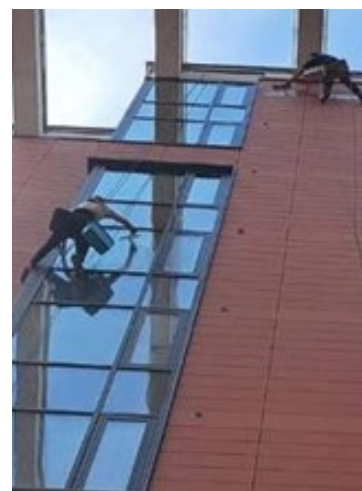
Помывка остекление фасада
