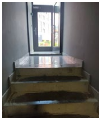
Помывка незадымляемых лестниц
