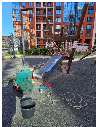
Ремонт детской площадки
