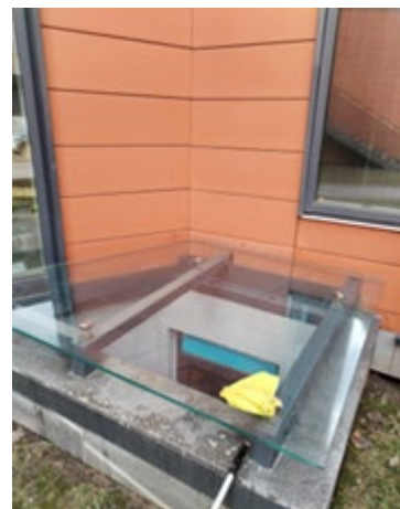
Помывка световых проемов
