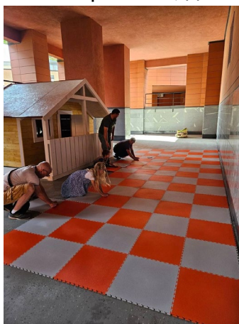
Укладка защитного пола
