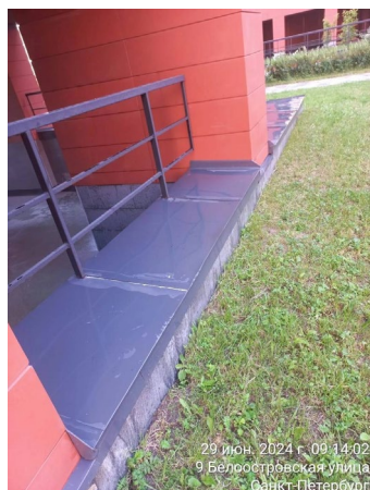
Помывка металлических ограждений
