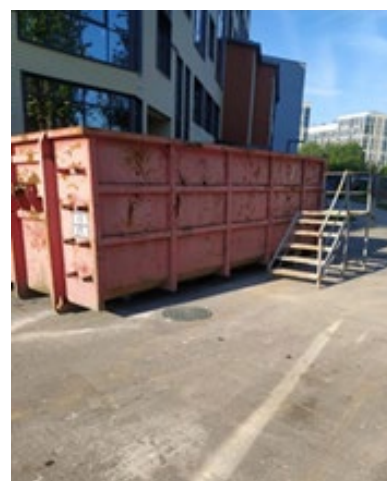
Уборка места сбора строительного мусора
